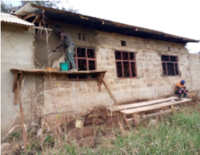
Letzte Verputzarbeiten am Lehrzimmer
